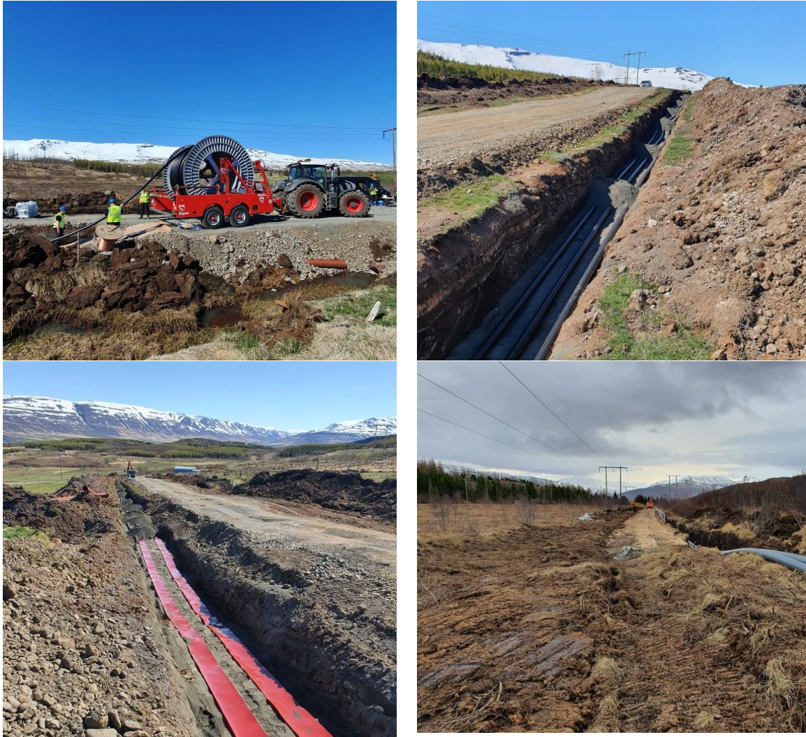
Mynd 3.5 Útdráttur strengs (Hólasandslína 3 á Akureyri). Upp til vinstri er strengkefli á útdráttarplani og útdráttur í gangi. Uppi til hægri eru allir þrír leiðarar komnir í skurðinn og byrjað að sanda yfir. Niðri til vinstri er byrjað að leggja varnarborða yfir sandinn. Niðri til hægri er búið að loka yfir vinstri skurðinn en verið er að leggja idráttarrör fyrir strenginn í hægri skurðinum.
