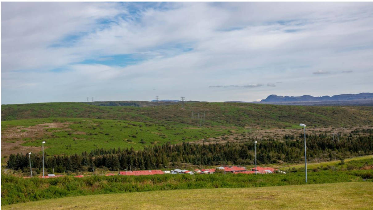
Mynd 4.9 Mynd tekin frá Skógarási í Hafnarfirði, horft til austurs í átt að Setbergshlíð. Hnoðraholtslína á mynd en búið að leggja Hamraneslínur 1 & 2 í jörðu um miðja mynd. Fyrir miðri mynd má sjá strengendavirki við niðurtökuna.
